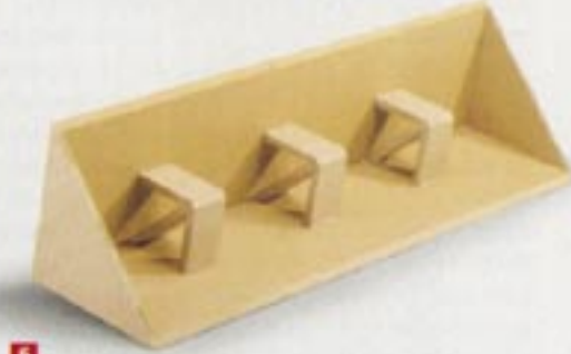
6 Setzen Sie sie an den Positionen aus der Zeichnung in den hinteren Winkel der Box und pressen Sie sie dort von Hand fest. Das reicht, da sie nicht sehr belastet werden
